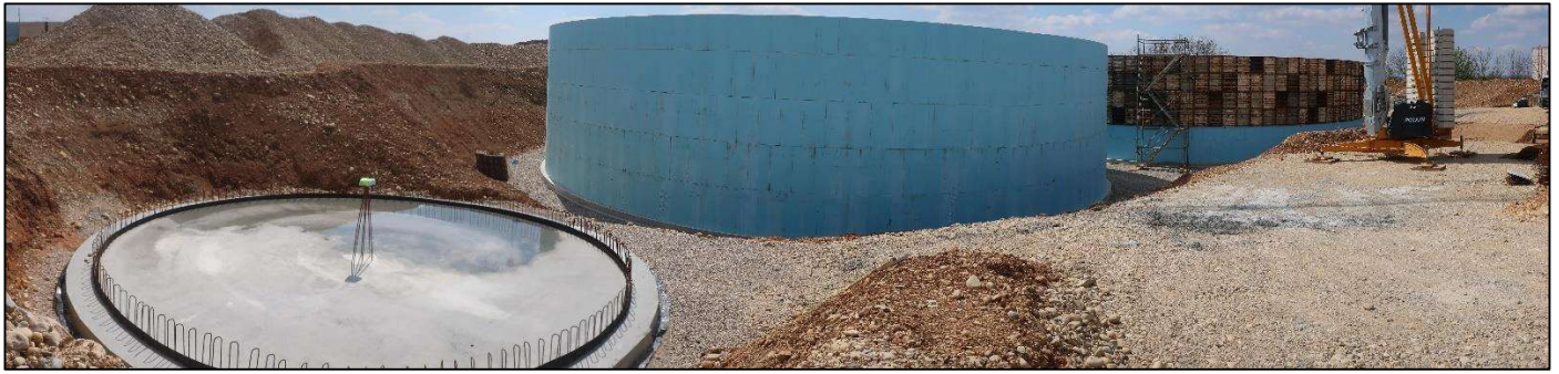
1- Unité en construction le 15 avril 2021
