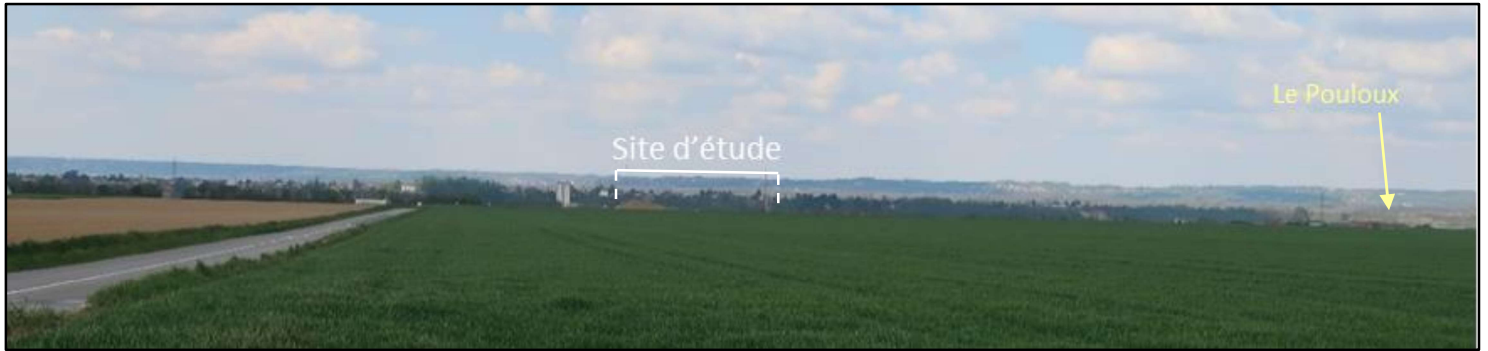
2 - Vue depuis l'intersection de la RD130 A et RD 73, au Sud-Ouest du site d'étude Source : ARTIFEX 2022
