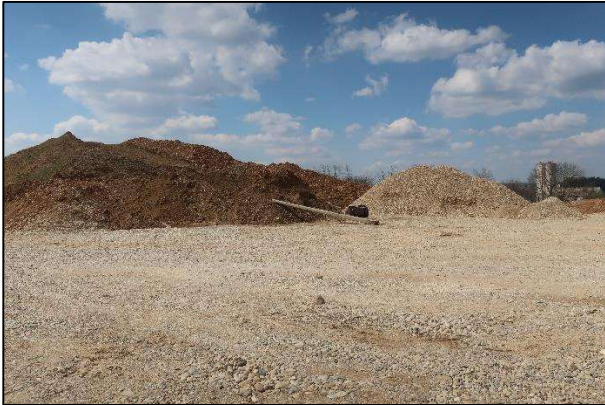
Unité de méthanisation en cours de construction
