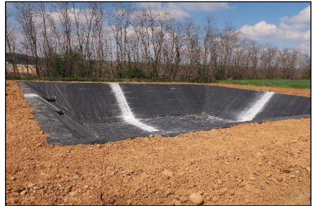
Bassin de rétention en construction
