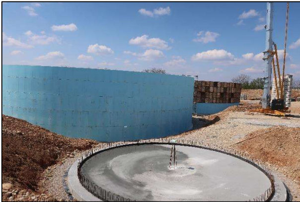
Digesteurs et pré-fosse en construction
