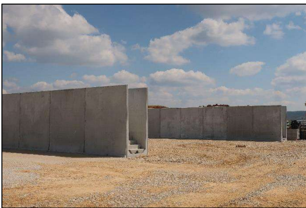
Silos en constructions
