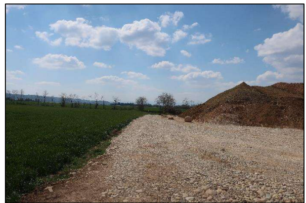
Chemin d'accès en construction
